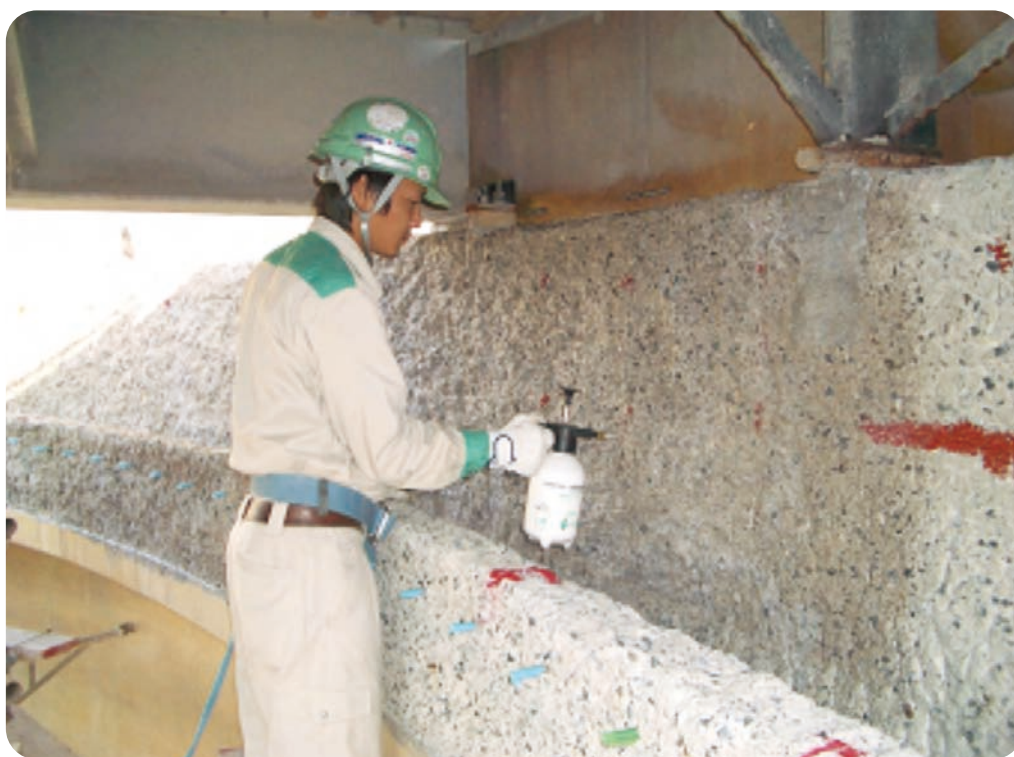
プライマー塗布
