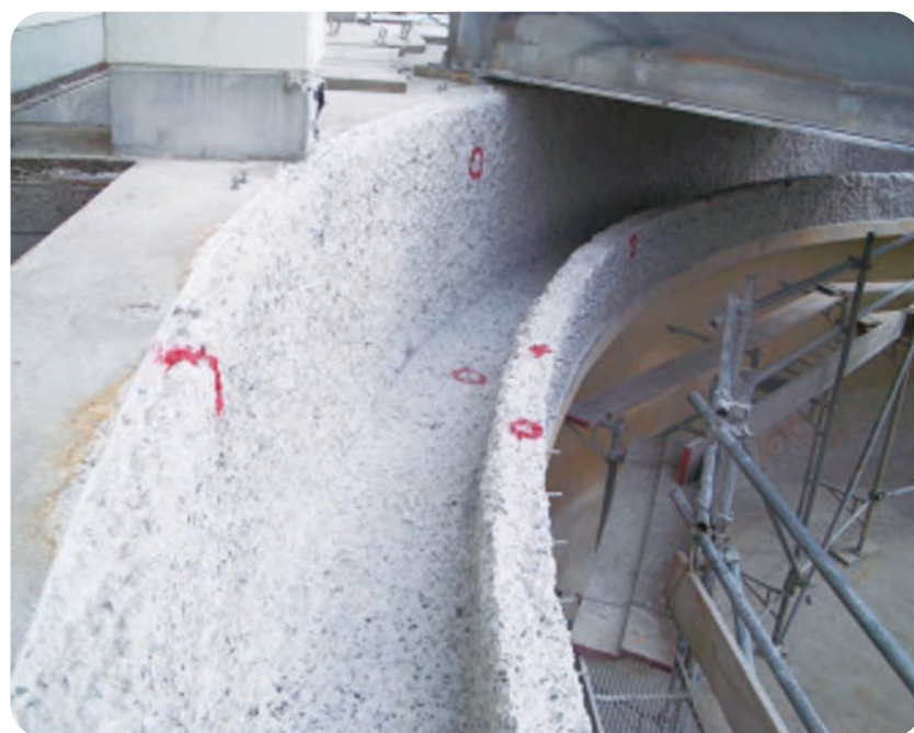
劣化部はつり処理
